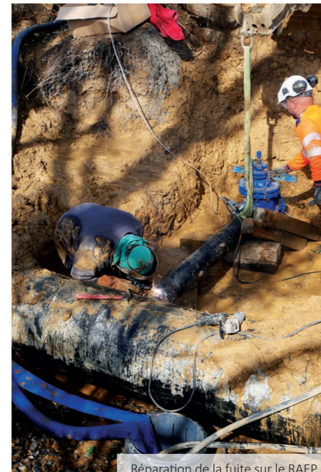
Réparation de la fuite sur le RAEP.
